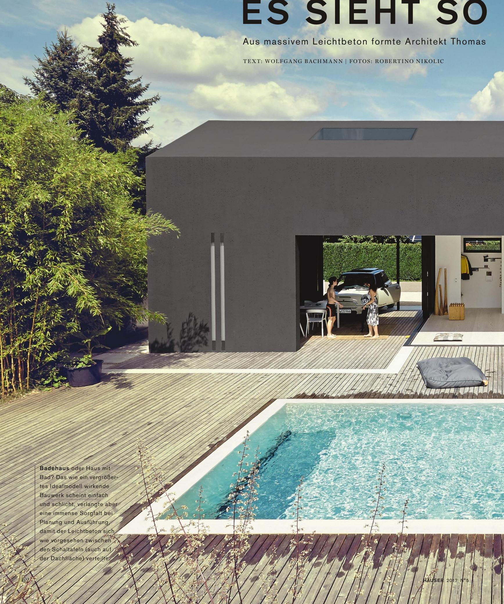
**Badehaus** oder Haus mit Bad? Das wie ein vergrößertes Idealmodell wirkende Bauwerk scheint einfach und schlicht, verlangte aber eine immense Sorgfalt bei Planung und Ausführung, damit der Leichtbeton sich wie vorgesehen zwischen den Schaltafeln (auch auf der Dachfläche) verteilte.
