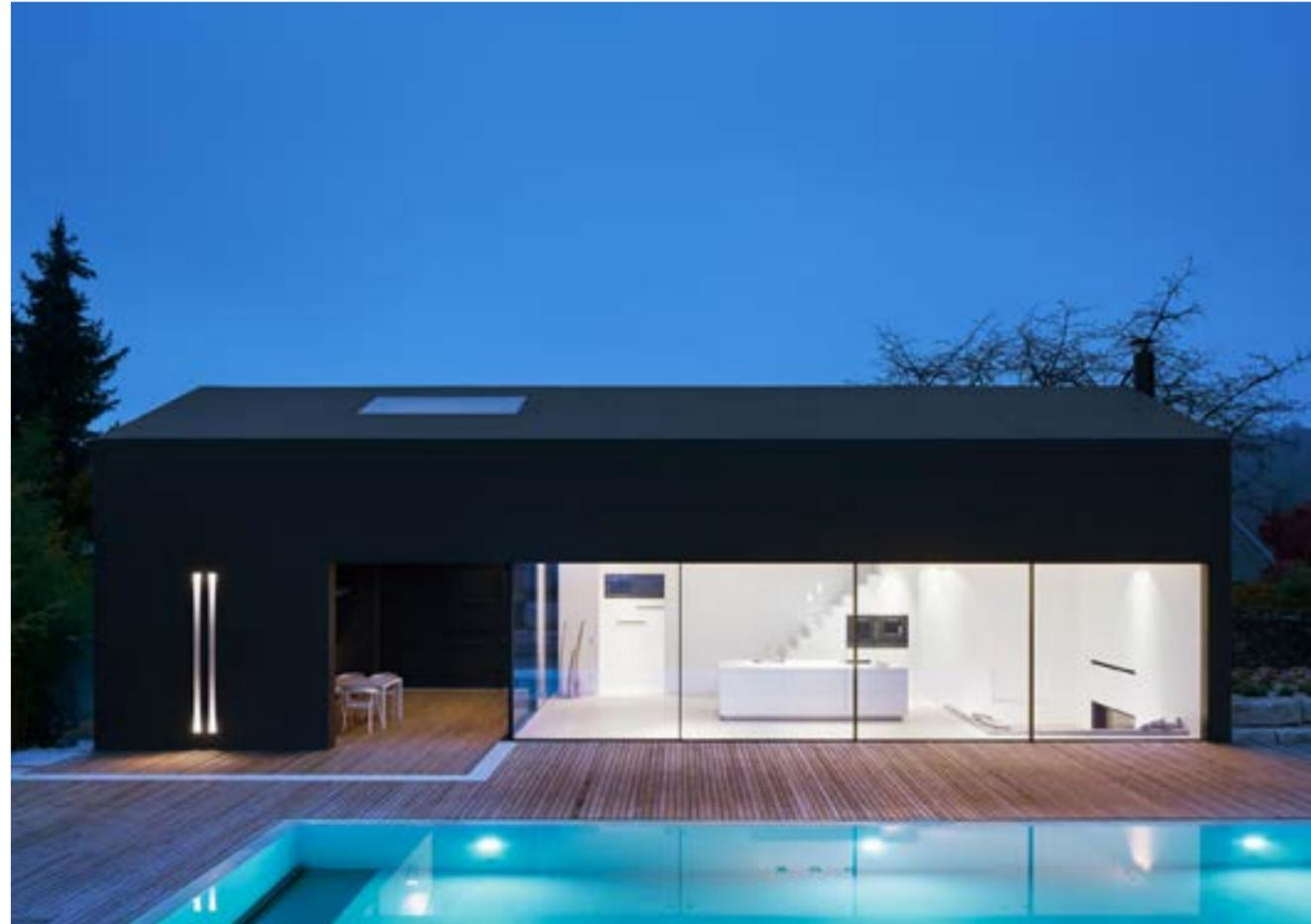
Das 2015 erbaute zweigeschossige Wochenendhaus in Bammental erscheint als dunkler Monolith, dessen Wände und Dach einheitlich in Leichtbeton realisiert wurden, ohne bauliche Ergänzungen oder Fassadendetails. Derart folgt es dem Leitmotiv eines kantigen, ausgehöhlten Steins, der sich – egal von welcher Seite man sich ihm nähert – als »silent rock« unaufdringlich in die umgebende Landschaft einfügt und eine Symbiose aus Architektur und Natur herstellt.
